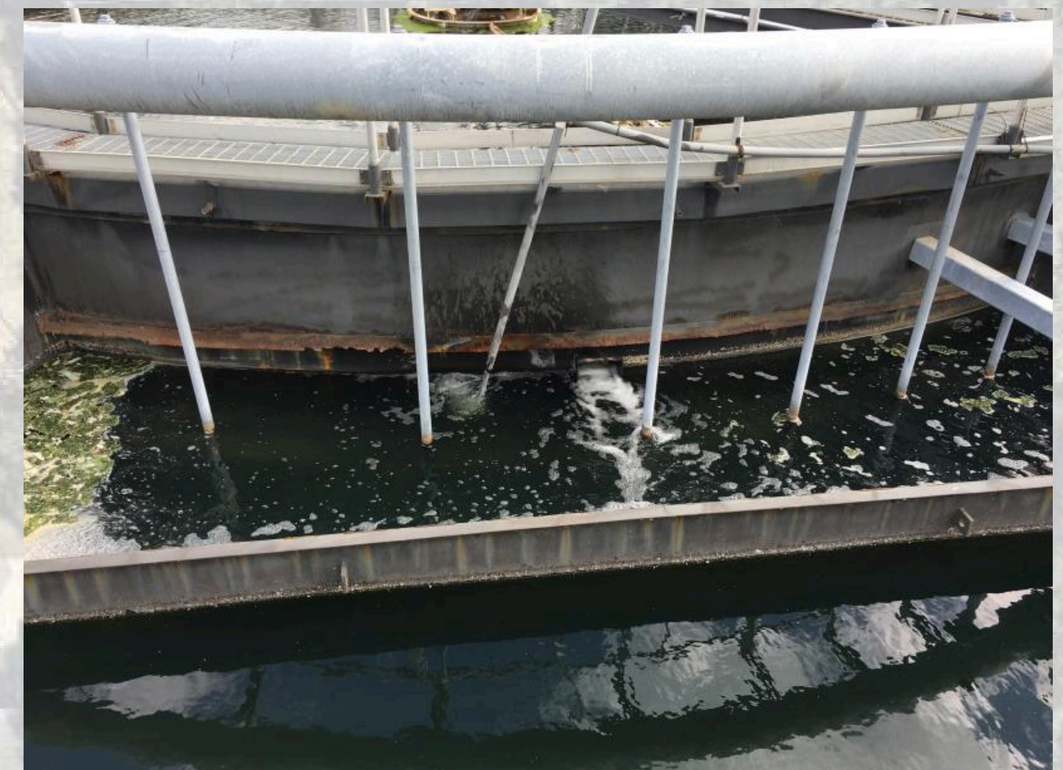
現存的 Bullseye MPU 內牆（加強筋腐蝕）
