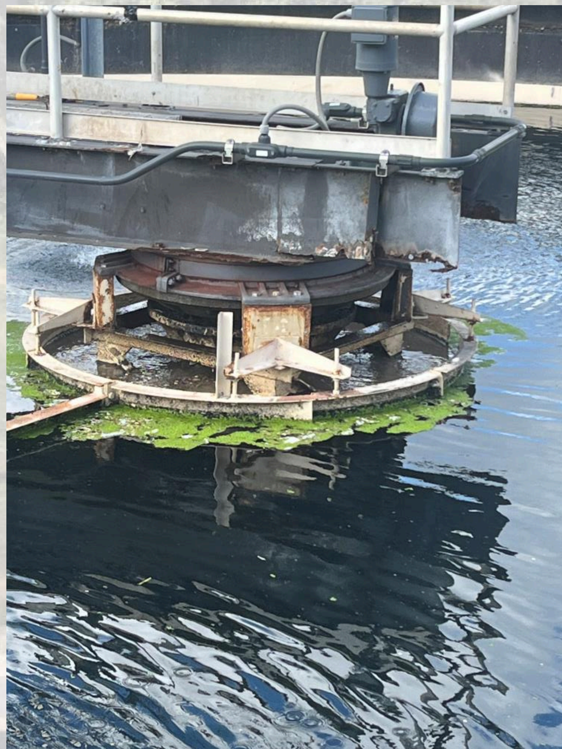
Hệ thống làm sạch hiện tại (Cầu bị ăn mòn & Cơ chế)
