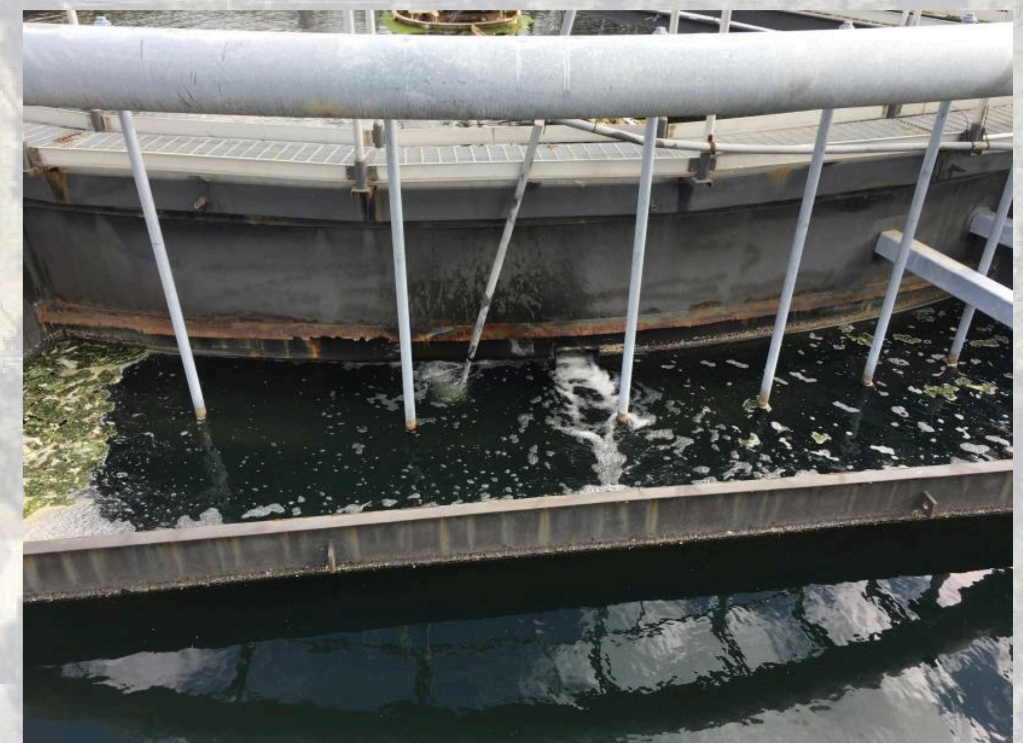
Tường Bên Trong Bullseye MPU Hiện Hữu (Chất làm cứng bị ăn mòn)
